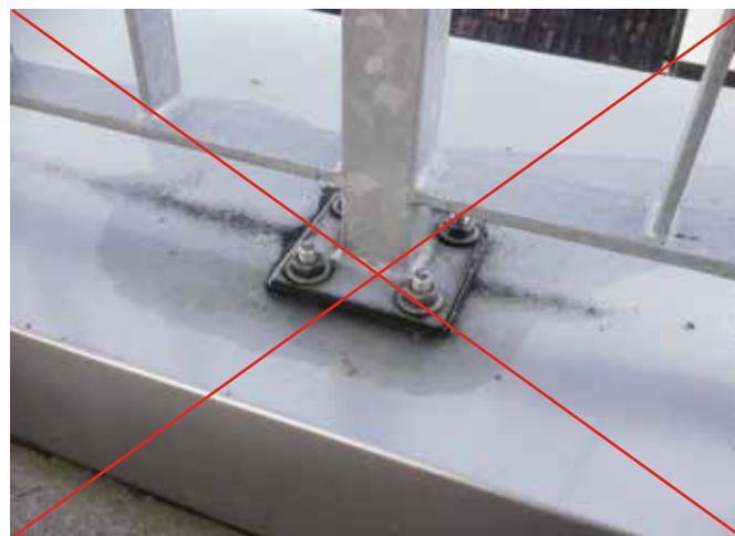
Fig. 7: Exécution défectueuse, inadmissible
